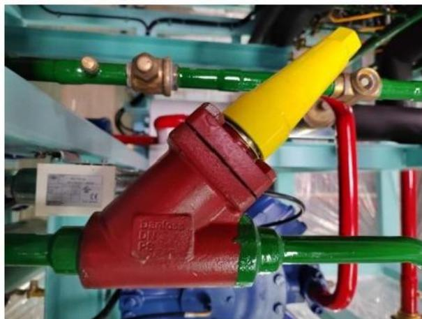
Figura 21 Válvula de expansión manual Chart 21 Manual Expansion Valve
