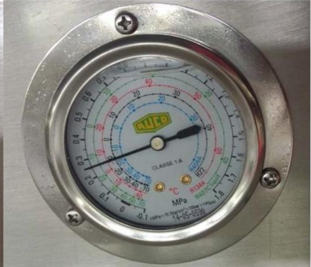
Figura 20 Manómetros de presión baja y baja Chart 20 High & Low Pressure Gauge
