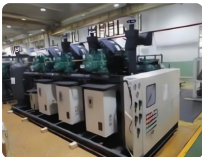
Rack de compresores rotativos de tornillo de doble línea de succión.
